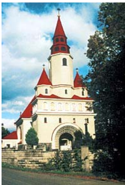
Neue Kirche in Taschendorf, erbaut 1906 (1997)
