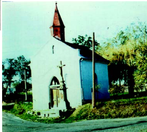
Kapelle, 1995 in Renovierung
