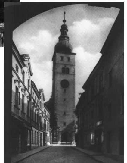
Turm der Pfarrkirche
