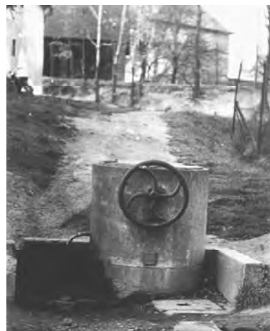
Pumpenvorrichtung bei einer der Sauerbrunnquellen zum Selbstzapfen (1960)
