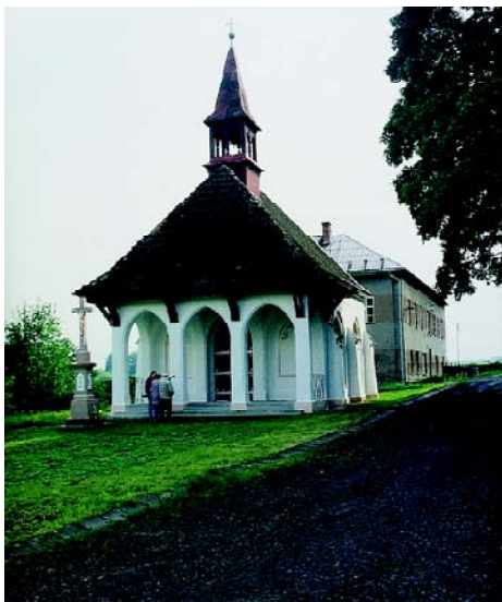
Im Jahre 1922 wurde für die Gefallenen des 1. Weltkrieges diese Gedächtniskapelle errichtet und eingeweiht (die Gedenktafeln wurden 1945/46 entfernt, sie sind seither verschwunden)
