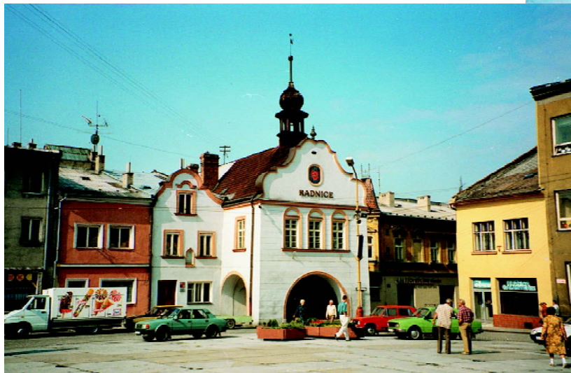
Das Rathaus in Wagstadt nach der Renovierung (1995)
