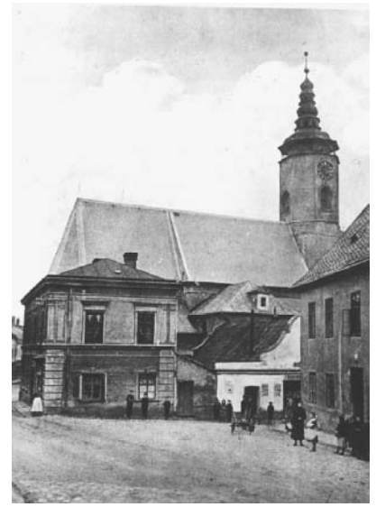
Kath. Pfarrhaus mit Kirche, die Häuser um die Kirche wurden 1946 abgerissen
