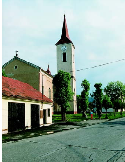
Kirche mit Feuerwehrhaus (Hauptstraße)
