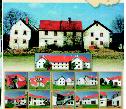
Projekt Sanierung Mendel-Geburtshaus in Heinzendorf/Hynčice
